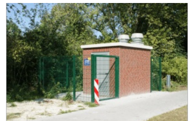
MSR-Station mit Be- und Entlüftung
