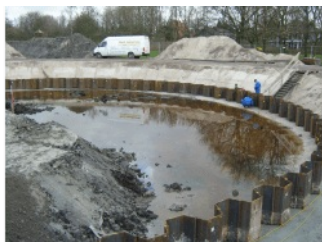
Spundwandverbau als verlorene Schalung
