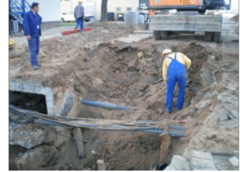
schwierige Untergrundverhältnisse bei Bauen im Bestand
