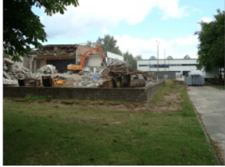
Rückbau altes Betreuungsgebäude
