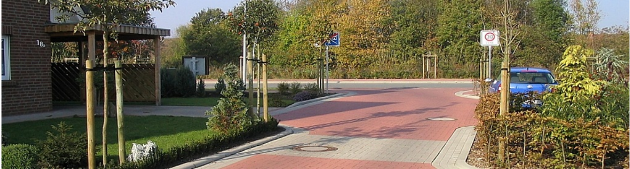
Fahrbahneinengung, fertige Straße
