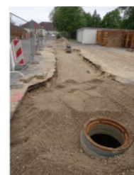
Sanierung Regenwasseranlagen
