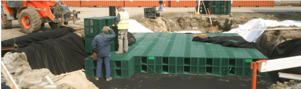
Verlegung von Speicherelementen
