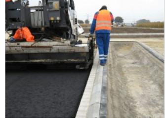
Einbau Asphalttragschicht
