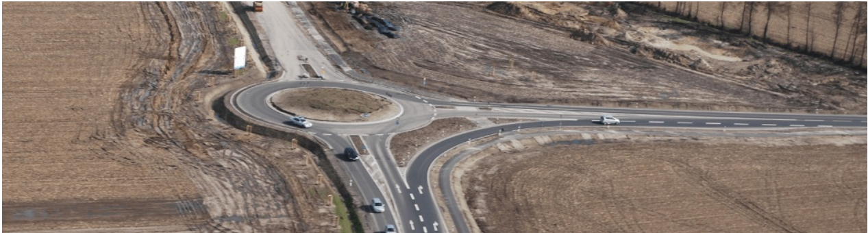
Bauanfang mit Kreisverkehr
