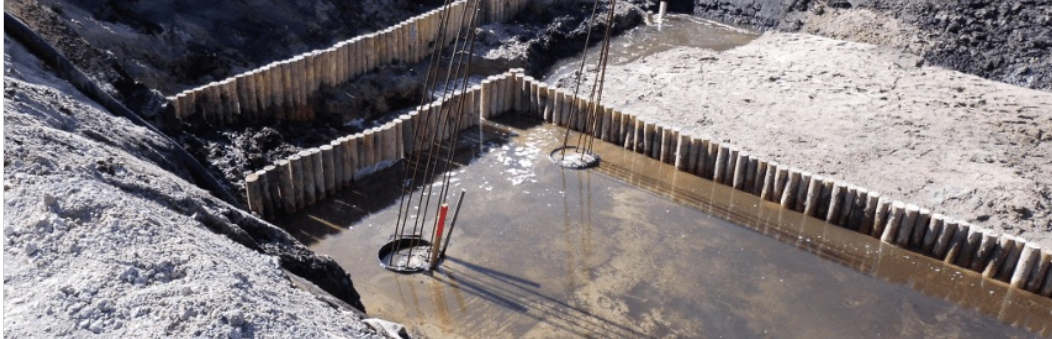
Baugrube mit Bohrpfehlen
