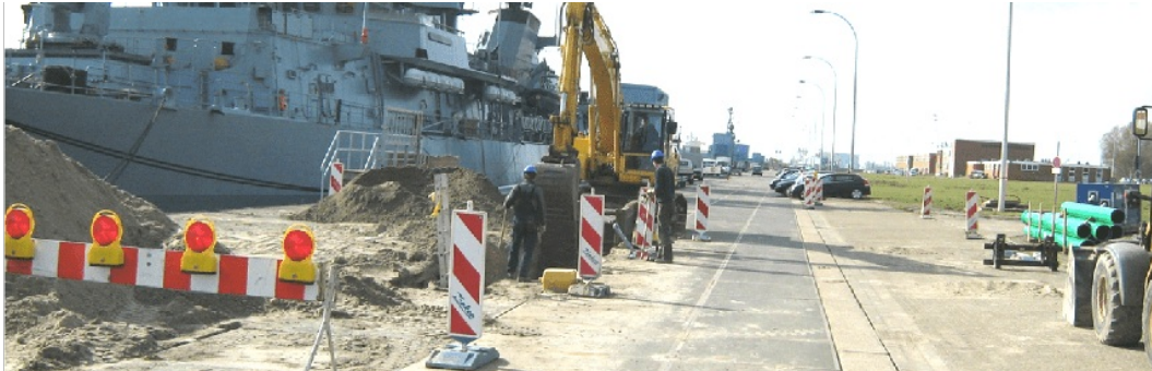
Arbeiten an der Westkaje
