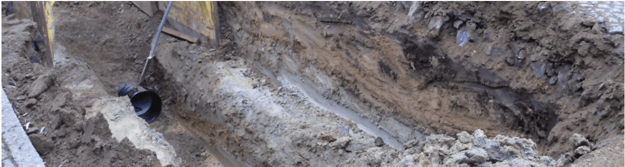
erschwerte Baugrundverhältnisse, Bodenklasse 5 und 6
