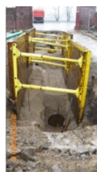
verbauter Stufengraben
